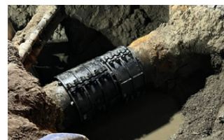
割継輪(修繕バンド)による修繕
